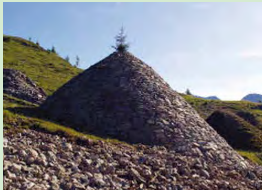
Wildbach- und Lawinerverbauung am Gamma, Lessach/Österreich, 19 Stein- und 22 begrünte Erdkegel (Quelle: Internet)
