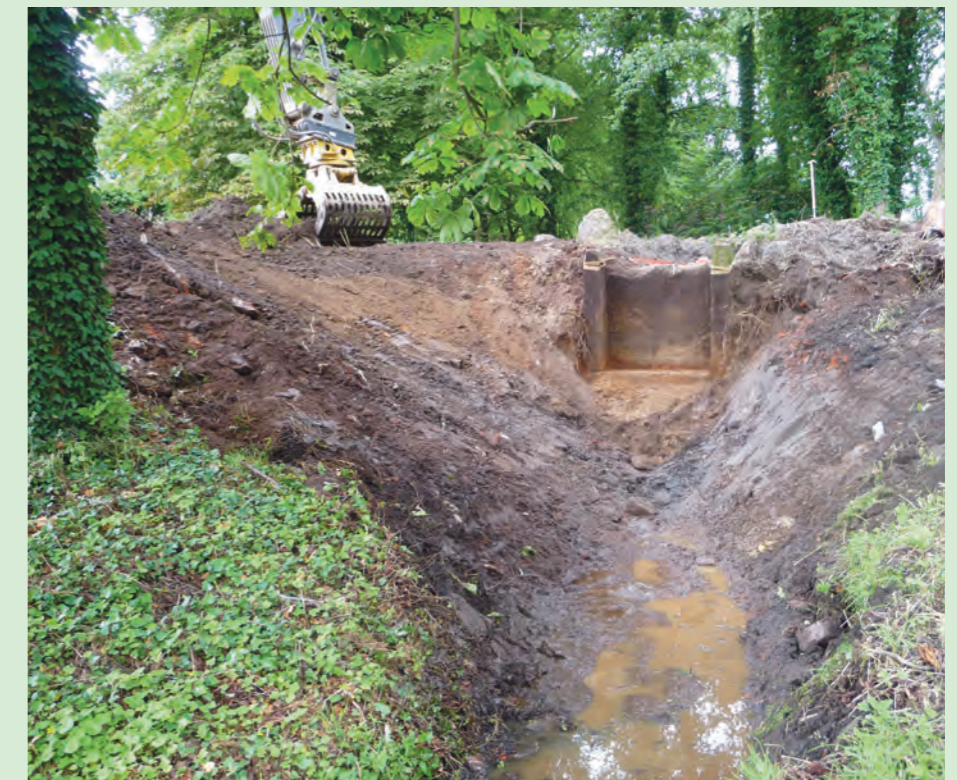
Freilegung des Wasserfalls, Juli 2012
